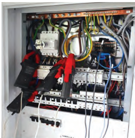
Rysunek 2. Podłączenie sond prądowych oraz napięciowych analizatora jakości energii elektrycznej w rozdzielnic nN
