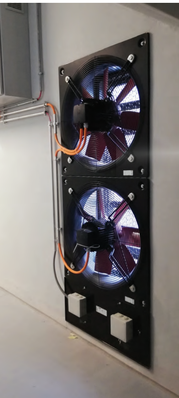
Przepustnica do napływu powietrza kompensacyjnego z wentylatorem mechanicznym w systemach kontroli rozprzestrzeniania dymu i ciepła – zespół napowietrzający ZNZ.
