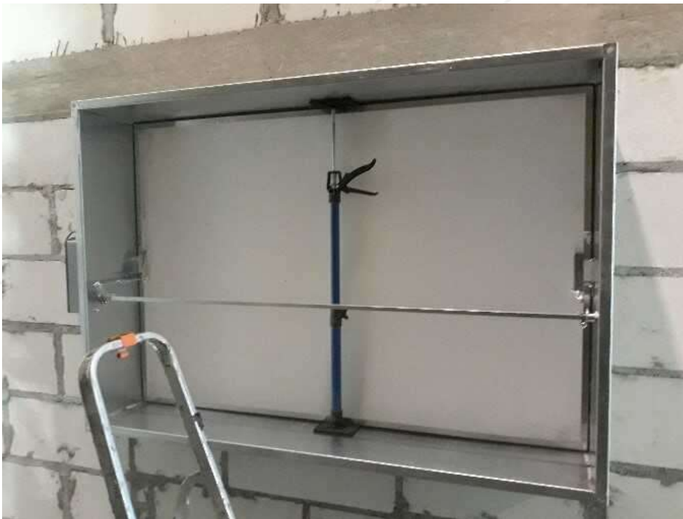
Rysunek 1. Prawidłowe przygotowanie klapy do zabudowy – zastosowanie rozpórki zabezpieczającej przed wgnieceniem korpusu klapy.
