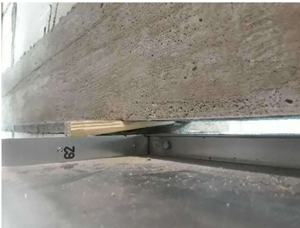
Rysunek 4. Poprawne przygotowanie klapy do zabudowy – zastosowanie klinów montażowych pomagających w poprawnym ustawieniu klapy
