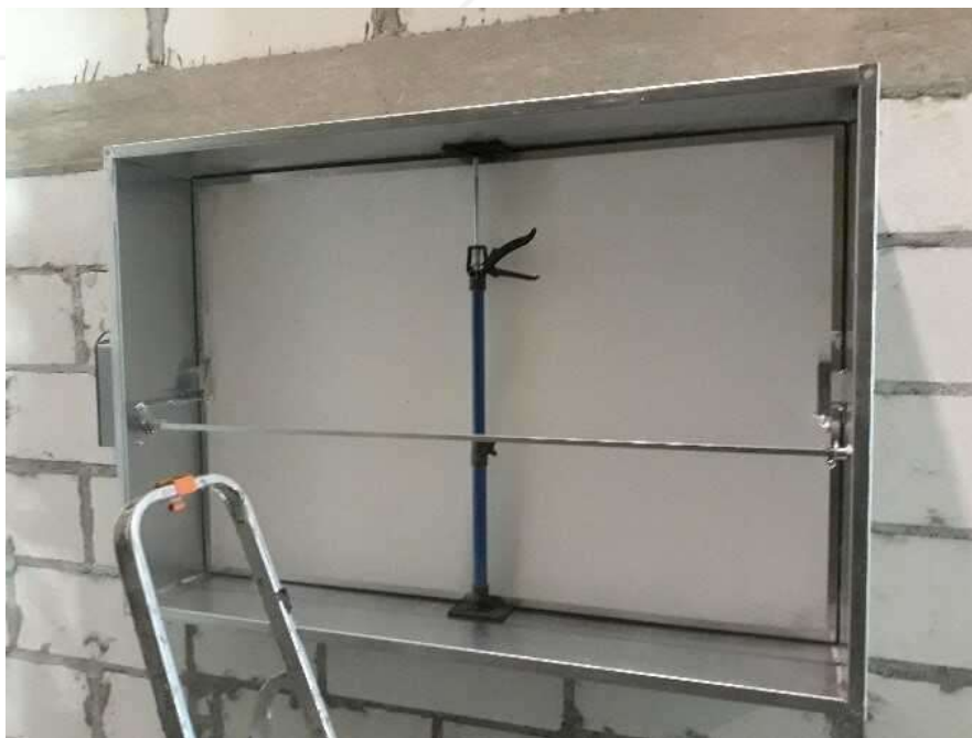
Rysunek 2. Prawidłowe przygotowanie kłapy do zabudowy – zastosowanie rozpórki zabezpieczającej przed wgnieceniem korpusu kłapy.
