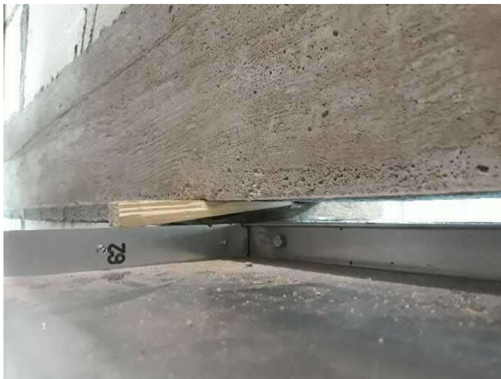
Rysunek 3. Poprawne przygotowanie klapy do zabudowy – zastosowanie klinów montażowych pomagających w poprawnym ustawieniu klapy
