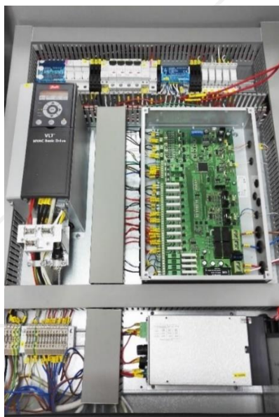
Rysunek 6.2 Moduł Zasilająco-Sterujący MZS-4 - widok wnętrza
